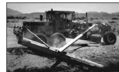
Movimiento de Tierra y Mantenimiento
